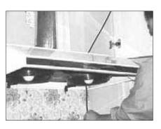
11. Faites passer le câble d'alimentation électrique par le trou préalablement percé ou utilisez un conducteur de mise à la terre #14 pour prise de courant.
