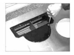
2. Placez l'adaptateur rectangulaire tel qu'indiqué sur l'image en fixant les 4 vis de la section en demi-lune.
