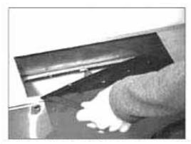
1. Retirez toutes les vis du couvercle rectangulaire arrière pré-monté et enlevez le couvercle ainsi que le joint d'étanchéité situés à l'arrière de la hotte.
