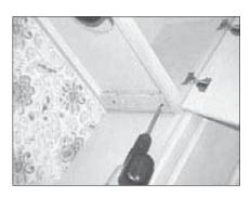
5. Renforcez la base de l'armoire avec des lattes de bois de 1 X 2 si un renforcement supplémentaire est nécessaire. Dévissez et enlevez la partie inférieure du couvercle anti-éclaboussure.
