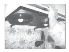
8. Soutenez la hotte et vissez la partie arrière à l'aide des deux vis et rondelles incluses dans la trousse.
