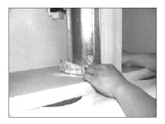
16. Joignez le conduit d'aération à l'ouverture de la hotte, scellez tous les joints avec du ruban adhésif en aluminium et vérifiez-en l'étanchéité.
