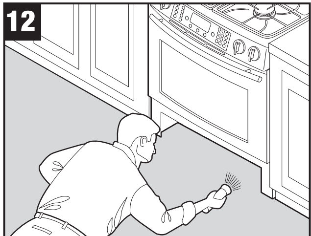
12 Check leg position in ANTI-TIP bracket./Vérifiez la position du pied dans la bride ANTI-BASCULEMENT./Verifique la posición de la pata en el soporte ANTIVUELCO.
