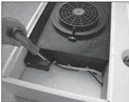
2. Retirez le couvercle de la boîte de jonction pour avoir accès au câblage électrique.
