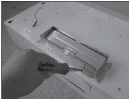
5. Fixez le collier de fixation principal de 3¼" x 10" avec registre sur l'ouverture du conduit d'aération à l'aide des 10 vis M4x8.
