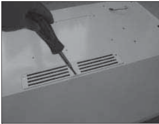
7. Placez les deux déflecteurs de reprise d'air sur l'ouverture supérieure et fixez-les en place à l'aide des vis préalablement enlevées.
